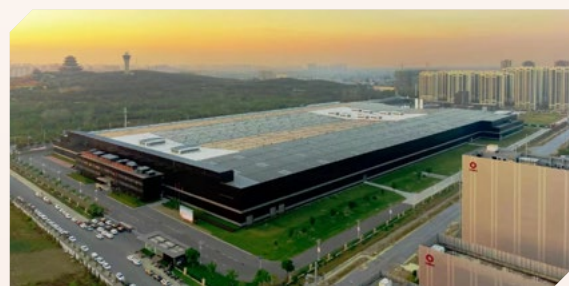
世界单体规模最大薄膜光伏建筑一体化应用示范项目
